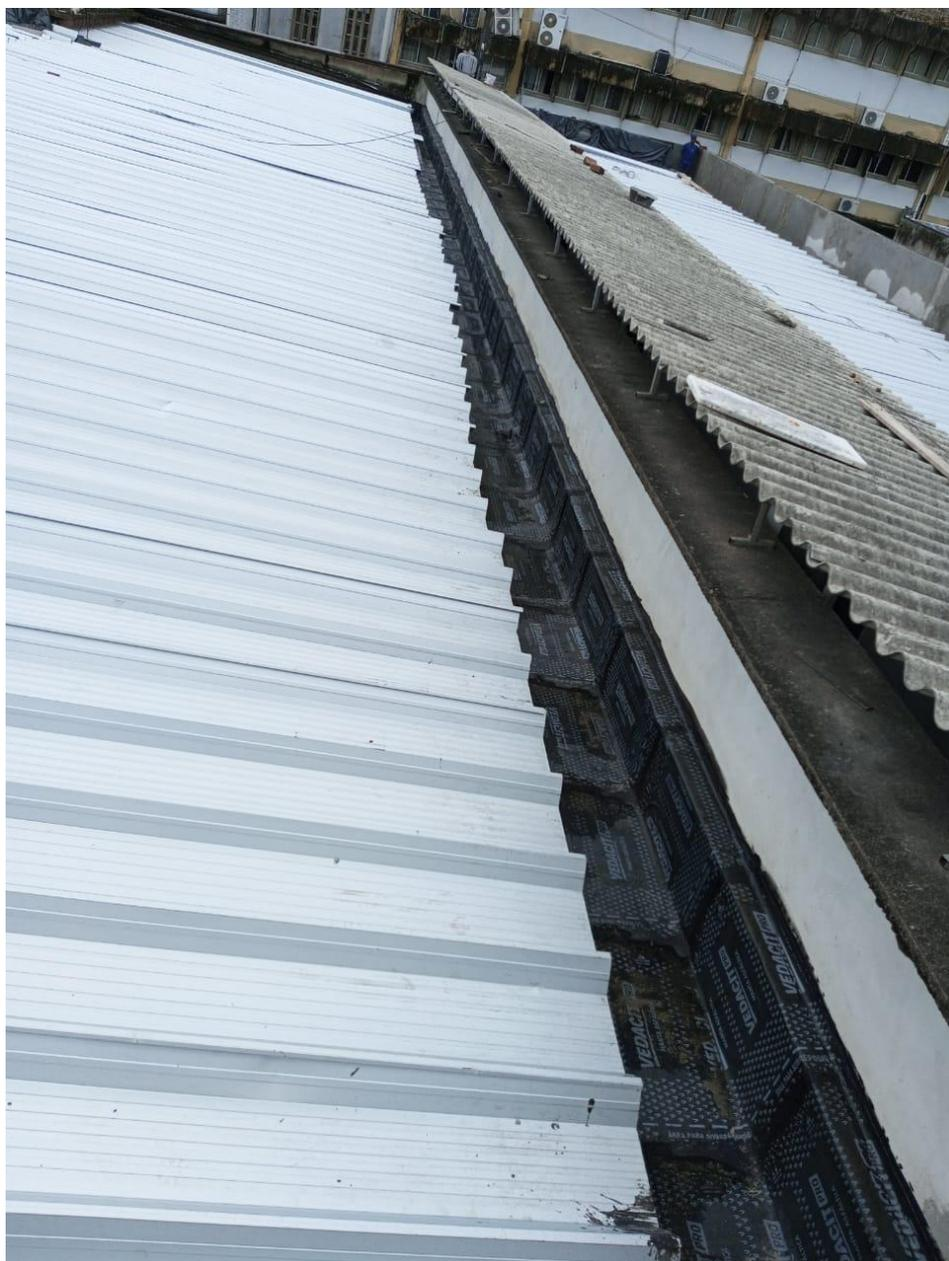
Início de alinhamento das telhas com a calha e impermeabilização da calha com manta asfáltica.
