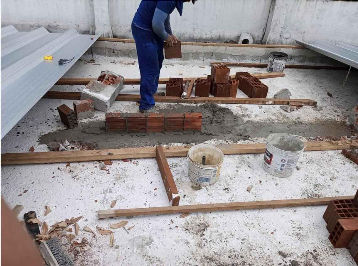
Elevação de alvenaria para recebimento da estrutura em madeira das telhas
