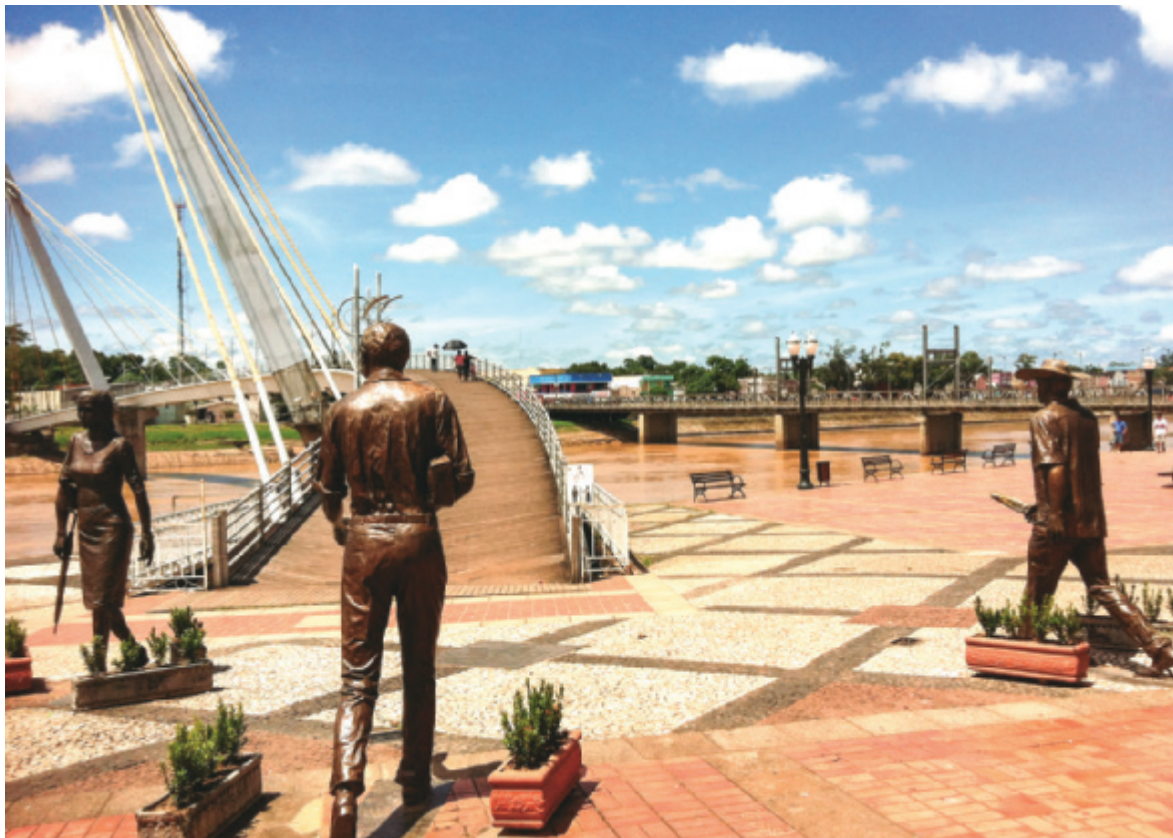
Figura 7. Presença de pontes transitáveis. Caminho percorrido por avaliador em Rio Branco, Acre.
